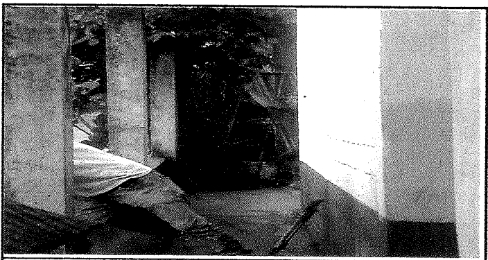
Foto 5: Reparacion de muro perimetral durante el proceso de la obra
