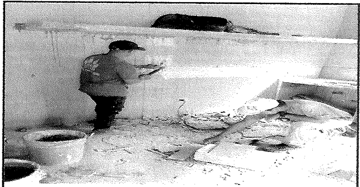
Foto 6: Área de cocina, durante el proceso de reparación
