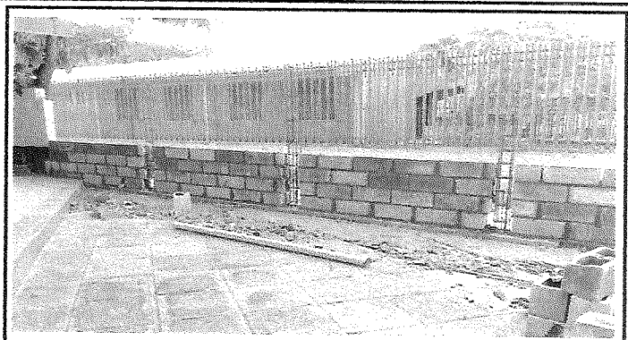
Foto2: levantamiento de muro en su reparación
