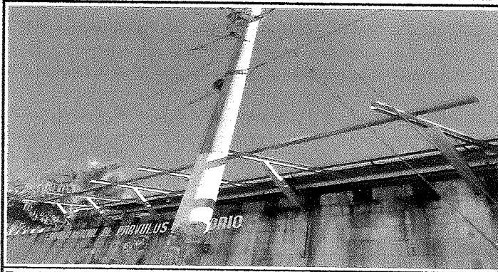
Foto1: Reparación de Muro durante la realización del proyecto de remozamiento
